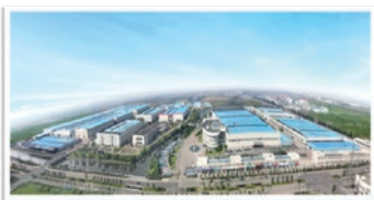
Ningbo (klimatyzatory, zasilanie, szpital)
