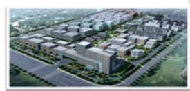
Chengdu (w trakcie budowy)
